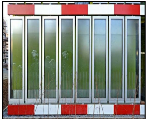
Glaspanele gevul met vloeibare biomassa-materiaal (alge) wat sy eie elektrisiteit kan voorsien.
